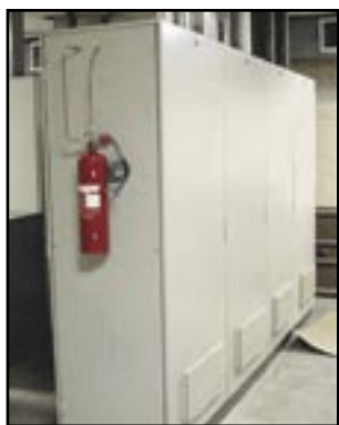
Пример внешнего монтажа АУП-01Ф-03
