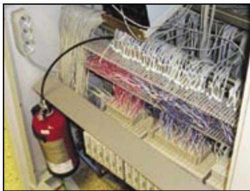
Пример внутреннего монтажа АУП-01Ф-01
